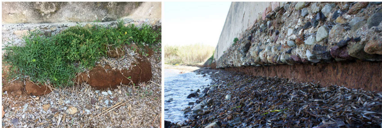
Fig. 8 – I substrati a matrice argillosa esposti dai fenomeni erosivi (a sin. affioramento presso il muro Foresi; a dex. la porzione del muro Foresi W subito prima del crollo del 2017, dove la sparizione di circa 1,20 m di spessore di spiaggia aveva lasciato scoperta non solo la fondazione, ma oltre mezzo metro di terra originaria su cui questa si appoggiava.
