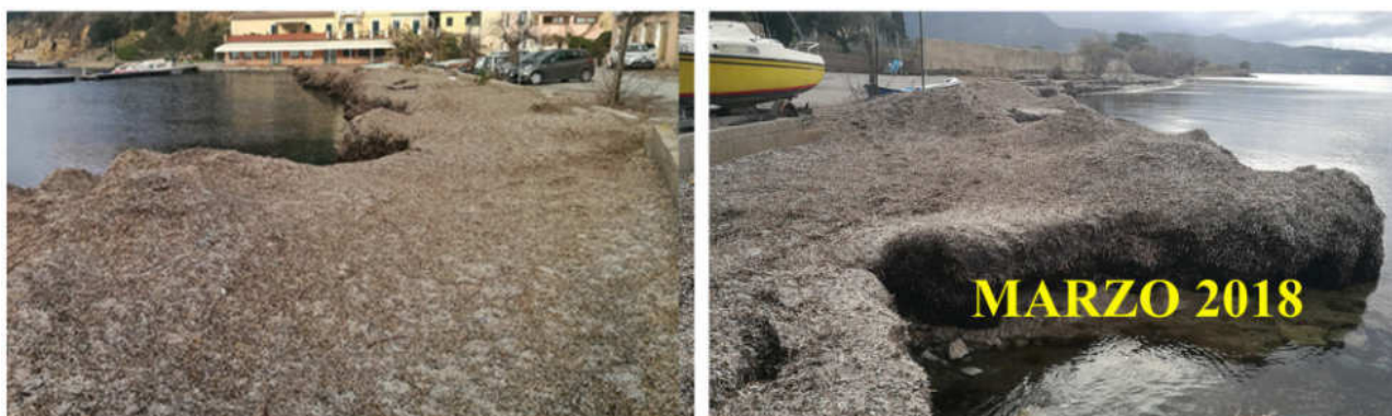
Fig. 1 – L’approdo di Magazzini intasato di sedimenti e di Posidonia spiaggiata, svuotato e di nuovo intasato in pochi mesi dalle correnti da W, evidentemente di gran lunga prevalenti su quelle da Est
