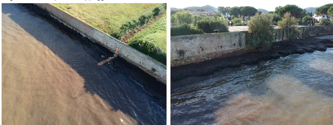
Fig. 9 - Il contatto col mare genera torbidità, anche in assenza di moto ondoso di una qualche rilevanza. Foto sinistra, parte destra, e foto a destra: la porzione ancora intatta del muro storico, a contatto con l'acqua, tende a sgretolarsi.
