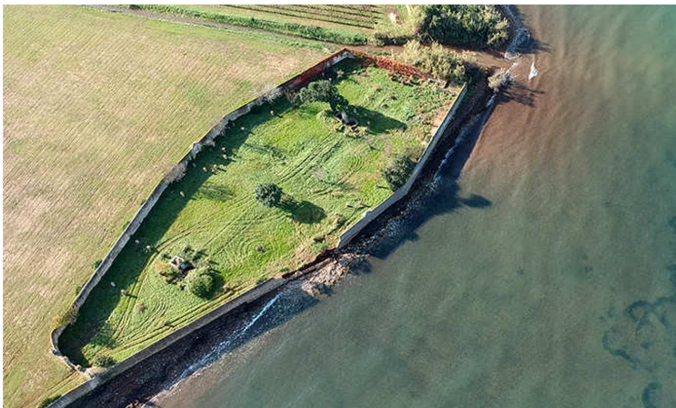
Foto 7 – Il muro lato mare della suggestiva “Nave” di Villa Foresi parzialmente demolito dall’azione delle onde, che come si vede sono in contatto con la sua base anche in condizioni di mare pressoché calmo.
