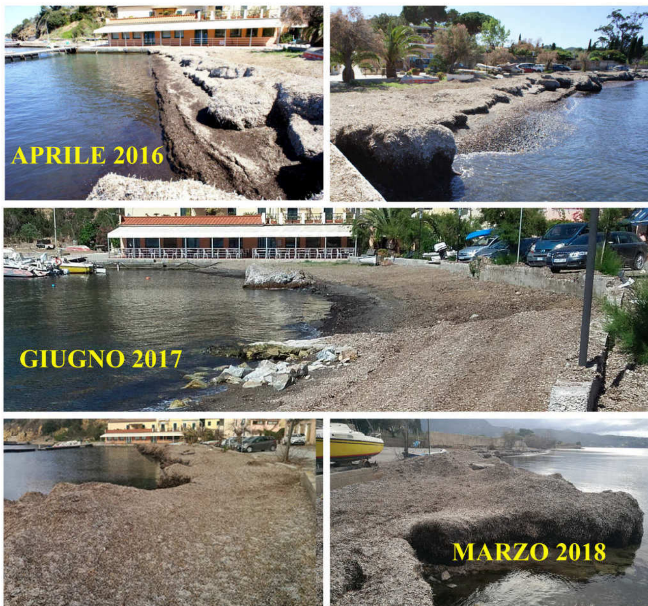
Fig. 5 – L'approdo di Magazzini intasato di sedimenti e di Posidonia spiaggiata, svuotato e di nuovo intasato in pochi mesi dalle correnti da W, evidentemente di gran lunga prevalenti su quelle da Est
