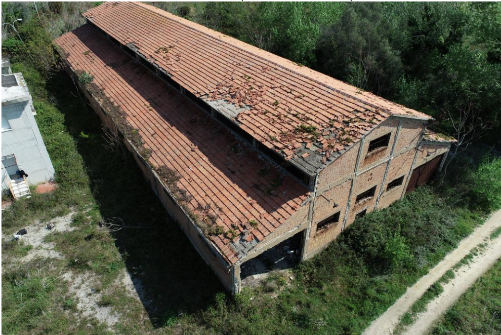
FOTO 4 (edificio da demolire)
