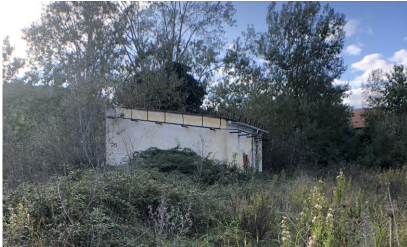
FOTO 5 (edificio da demolire)
