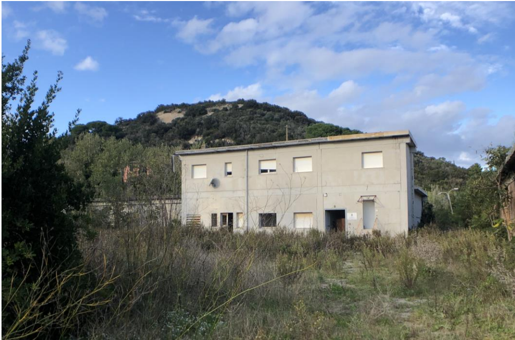
FOTO 3 (edificio da demolire)
