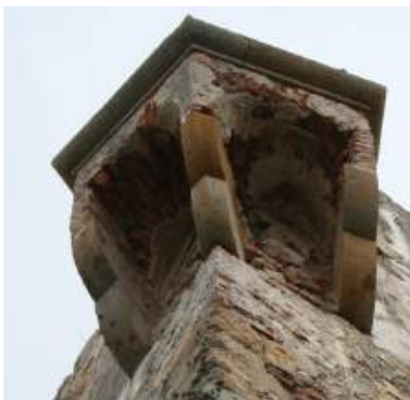
Illustrazione 3: Vista della garitta posta sullo spigolo del bastione soggetto a fenomeni di ribaltamento. Si noti l'avanzato stato di degrado delle murature
