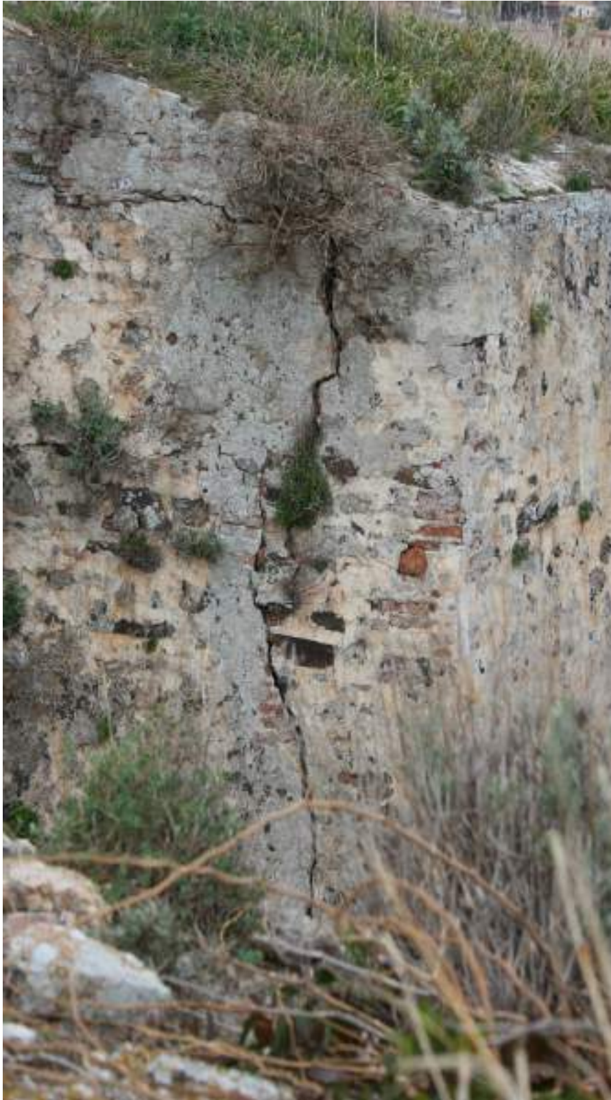
Illustrazione 2 - Dettaglio della lesione che percorre verticalmente il muro a gravità, rivelando il principio di ribaltamento del muro stesso.
