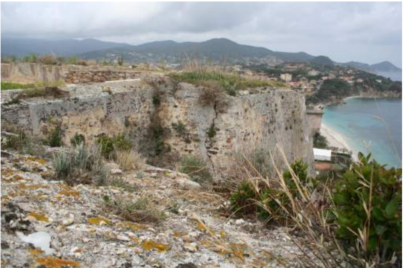
Illustrazione 1 - Vista del bastione. Si noti la lesione che percorre verticalmente il muro a gravità, rivelando il principio di ribaltamento del muro stesso.
