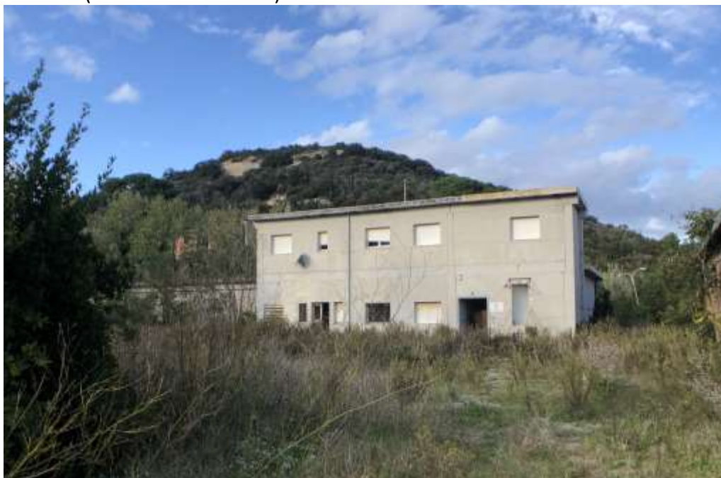
FOTO 5 (edificio da demolire)
