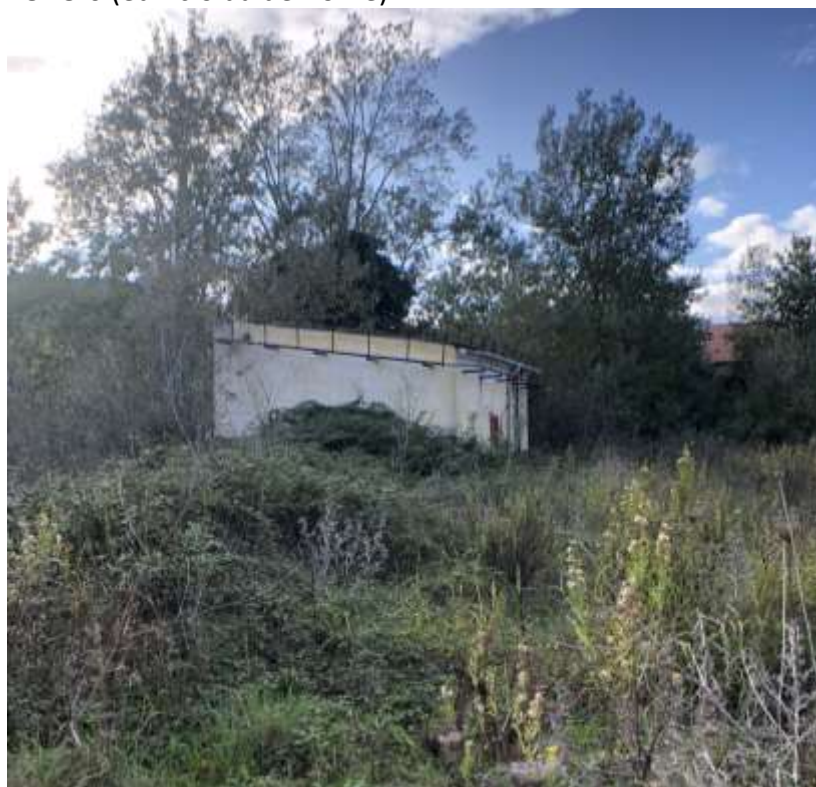
FOTO 6 (edificio da demolire)
