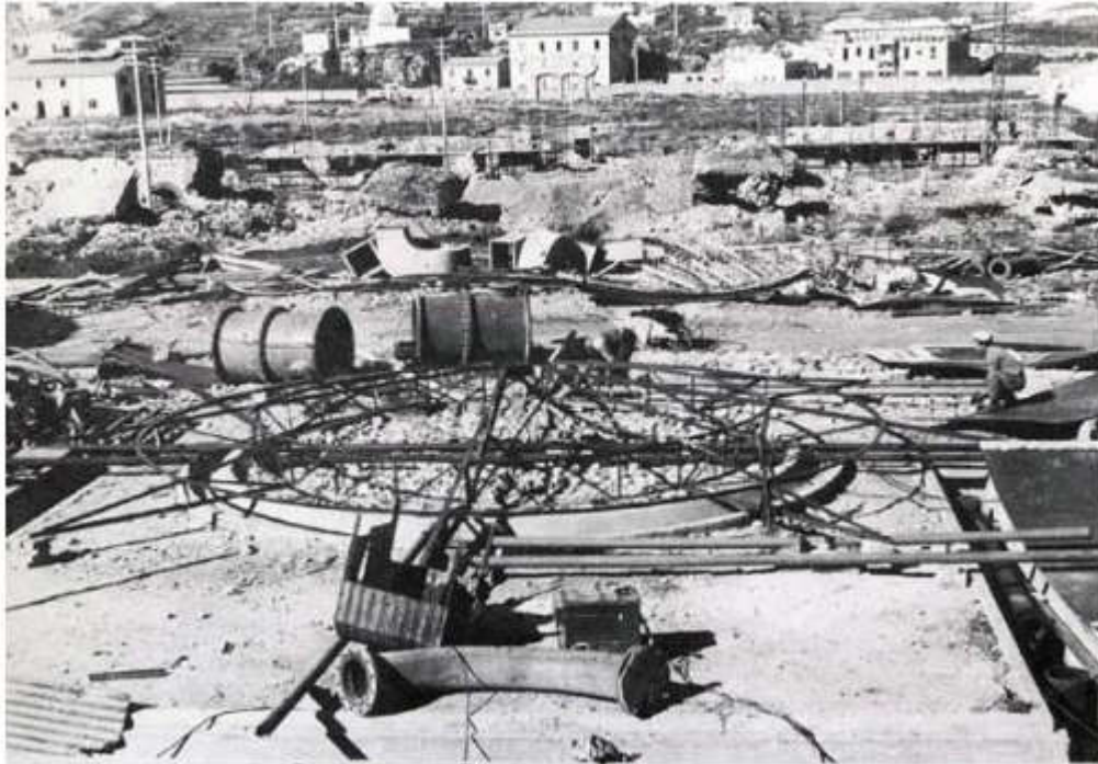
FOTO 3 La zona dove sorgevano le acciaierie all'indomani della loro demolizione
