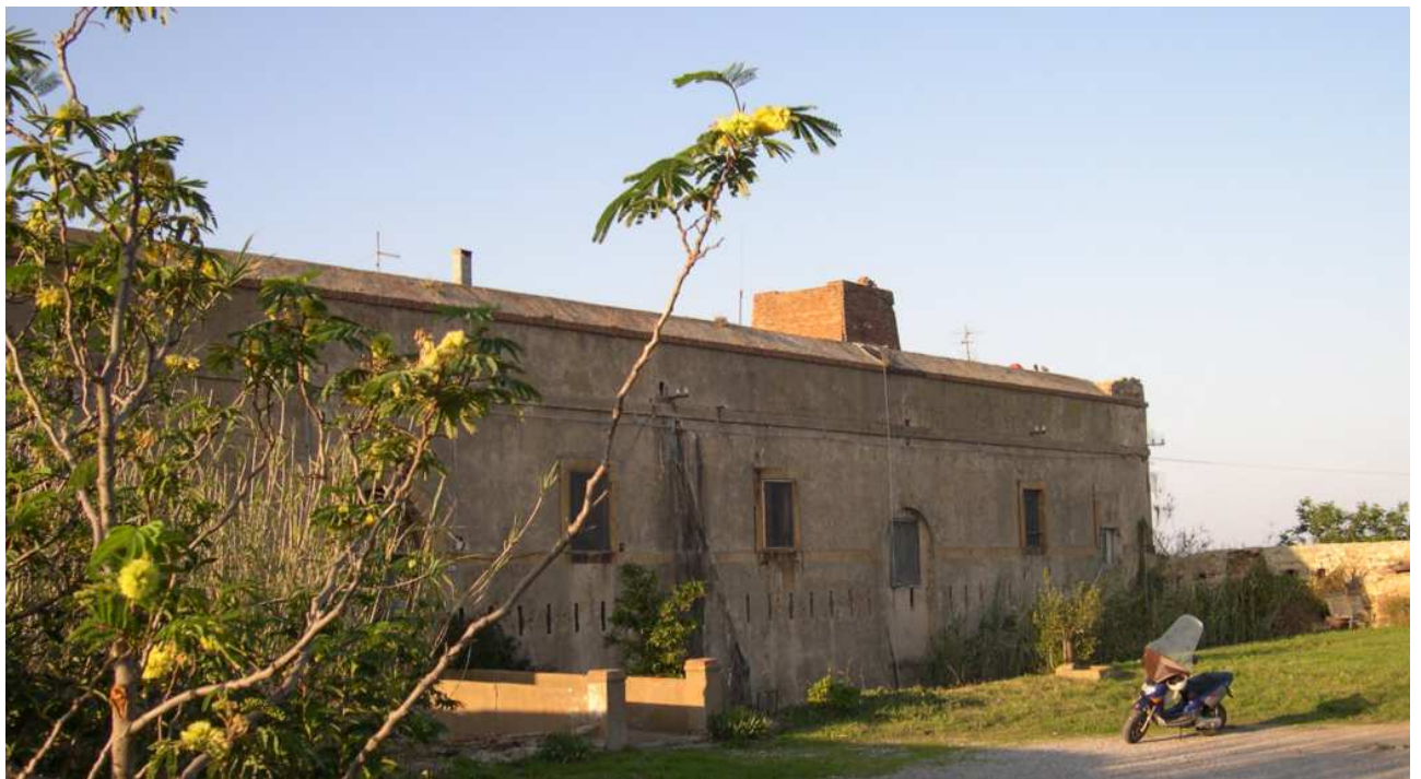
5.6 Bastione S.Rocco, bastione difensivo esterno realizzato successivamente all'epoca medicea, durante l'occupazione francese è unitamente al Forte Inglese e ai resti del forte di Montebello testimonianza del permanere della importanza strategico – militare del sito di Portoferraio, in gran parte la struttura è inesplorata.
