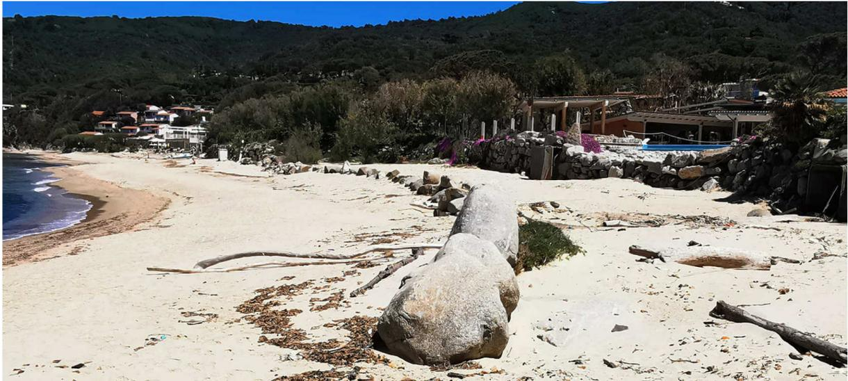
Foto n. 1 – Massi ciclopici (anche su due barriere) a protezione dell'entroterra, ma deleteri per la spiaggia
